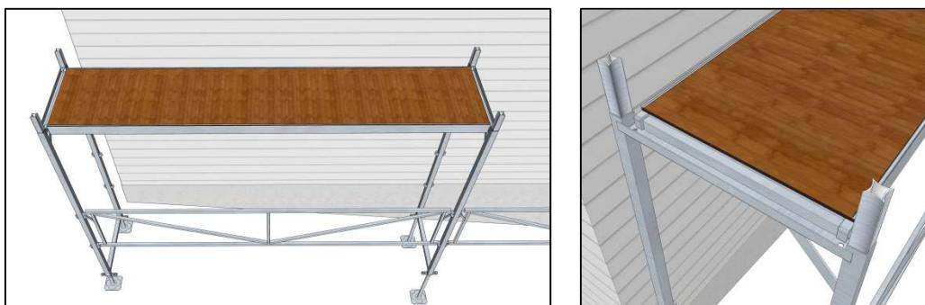
Dette gjøres mest ergonomisk ved først å legge plattformen inn over en ramme, mellom rammens «stusser» (fig. A), for så å løfte den opp og forsiktig føre den tilbake og inn over den andre rammen (fig. B), inntil krokprofilene på plattformen hektes ned i U-profiler på rammene. Sjekk så at plattformene er i vater (fig. C).
