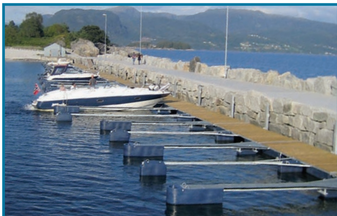
Landgang med dobbelt rekkverk og rampe for adkomst for rullestol og annet rullende materiell, produsert for NCC
