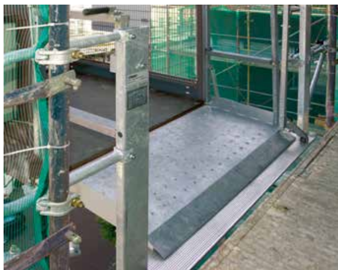
Lastesituasjon med åpen plattformrampe
