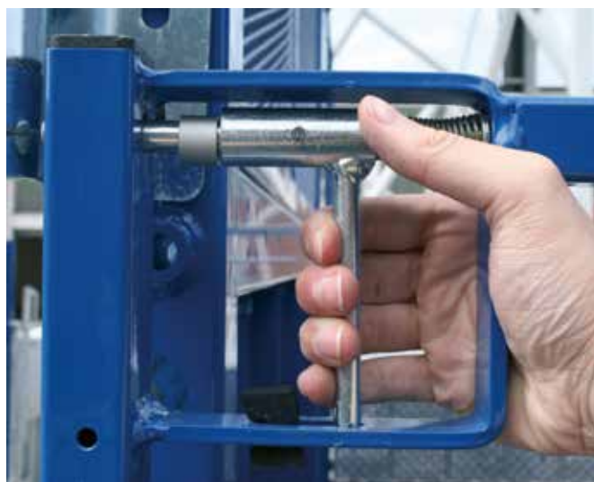
Sikker låsing av den hengslede porten med en enkel mekanisme
